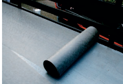
2. Schutzvlies gegen mechanische Schäden ausrollen.
