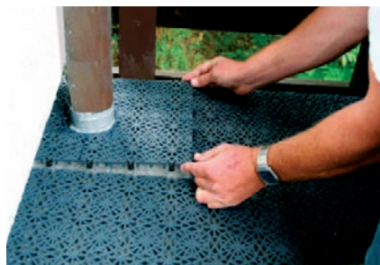
8. ... und passgenau um Rundungen und Durchdringungen legen.
