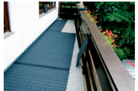
6. ... etwa nach allen 4–8 Platten-einheiten eine Expansionsleiste eingebaut werden.
