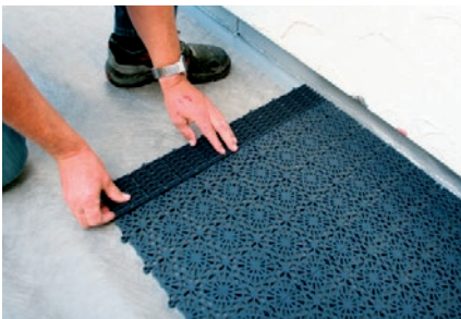
4. Enkefloor Bodenplatten mit ca. 10–20mm Wandabstand verlegen.
