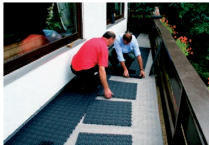
5. Für einen sicheren Dehnungsausgleich der Bodenplatten sollte ...
