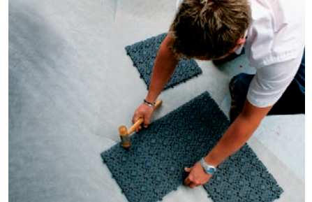
3. Enkefloor Bodenplatten zu größeren Einheiten zusammenfügen.
