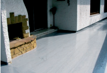
1. Boden reinigen, Enkopur®-Abdichtung auftragen und aushärten lassen.
