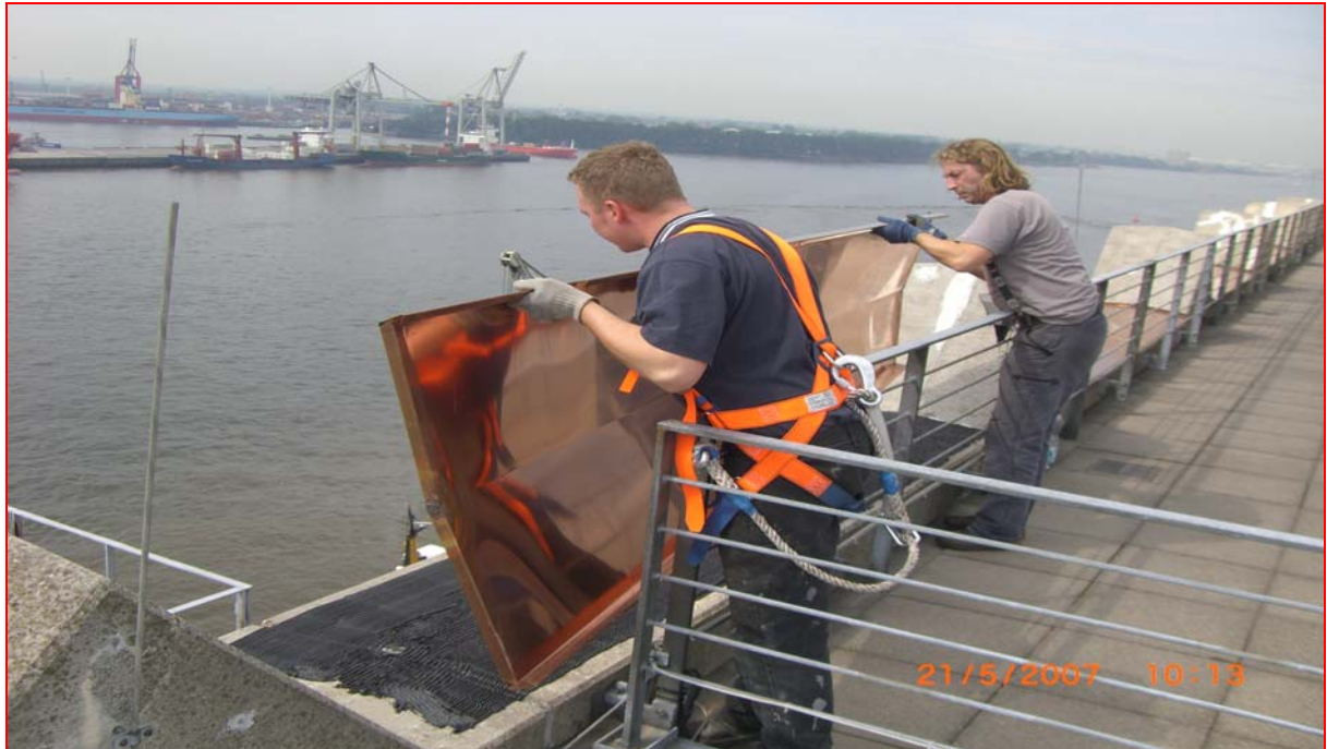
Bild 3: Auflegen der Bleche
