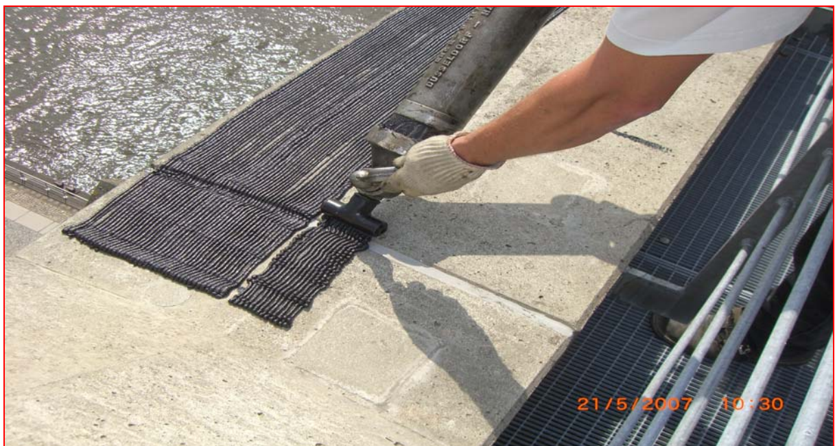
Bild 2: Enkolitauftrag mit einer 10 cm Düse, zur Abdeckung der gesamten Breite
