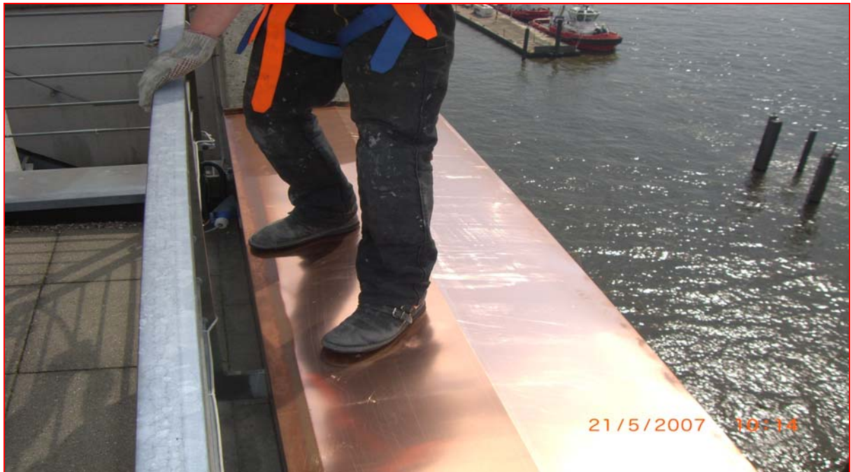
Bild 5: sicherheitshalber nachträgliches Antreten mit dem Fuß, damit die breiten Bleche auch überall wirklich vollflächig angedrückt sind
