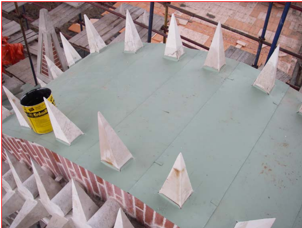
Bild 16 : Verklebte Abdeckung
