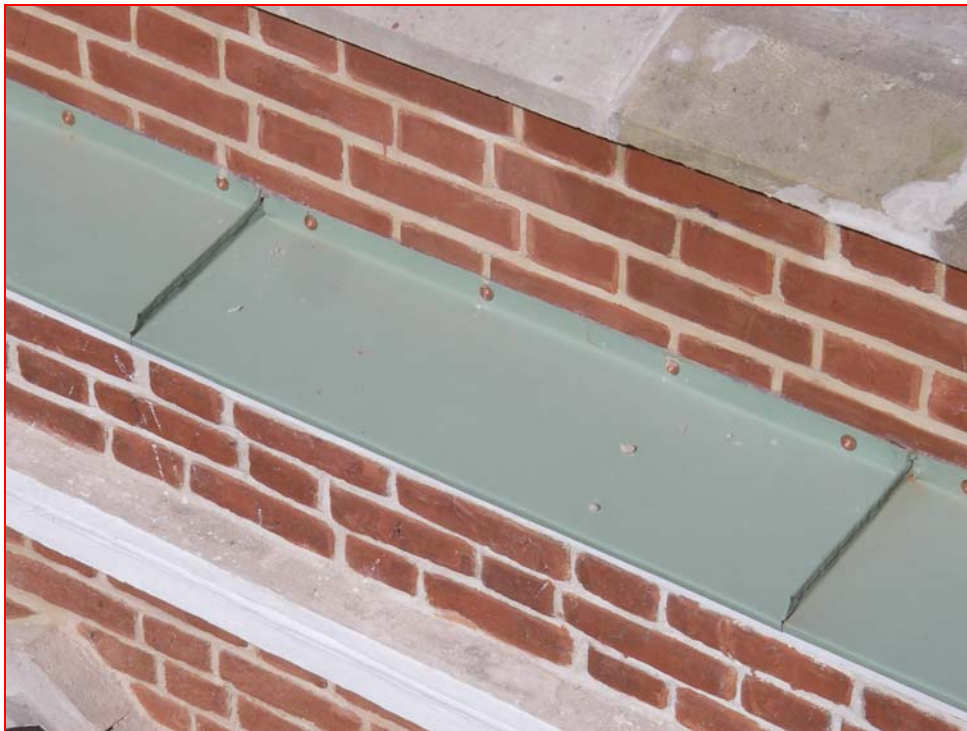
Bild 18 : Verklebte Gesimsabdeckung
