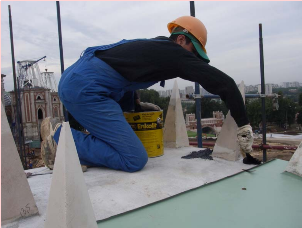
Bild 9 : Arbeiten mit ENKOLIT
