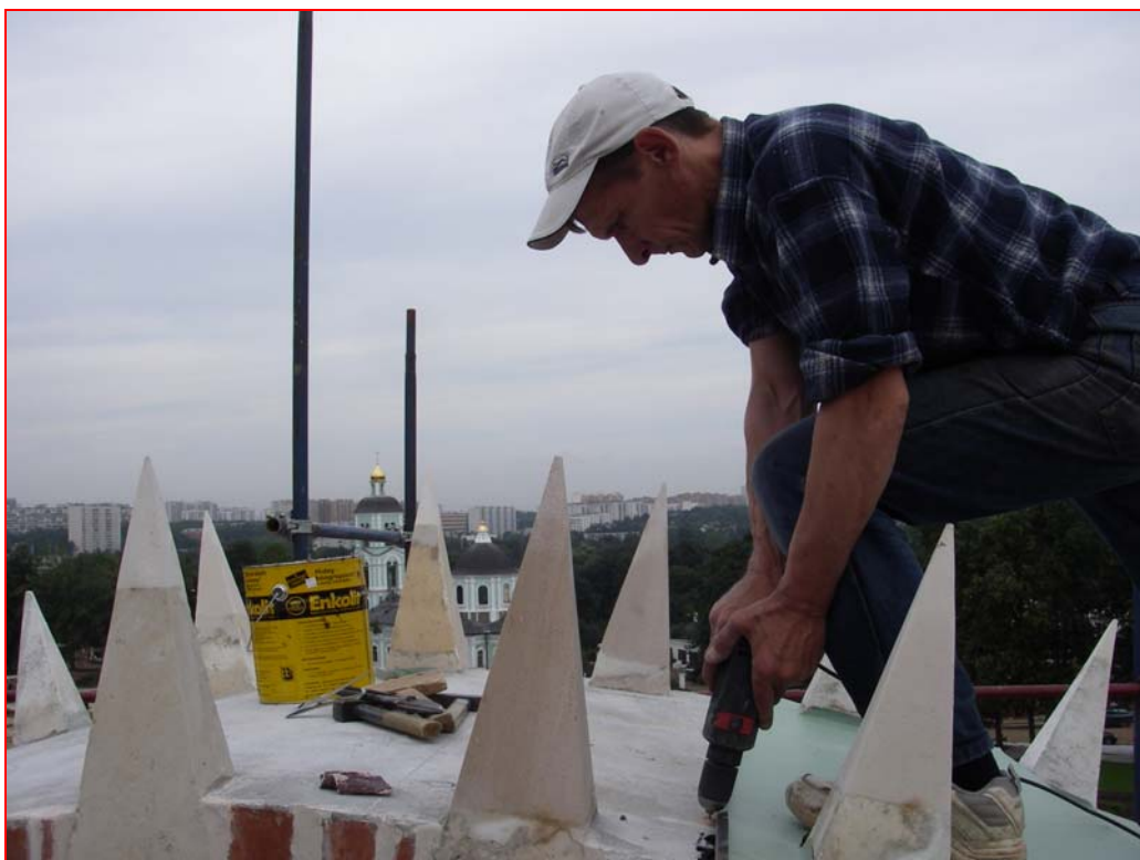
Bild 8 : Arbeiten mit ENKOLIT
