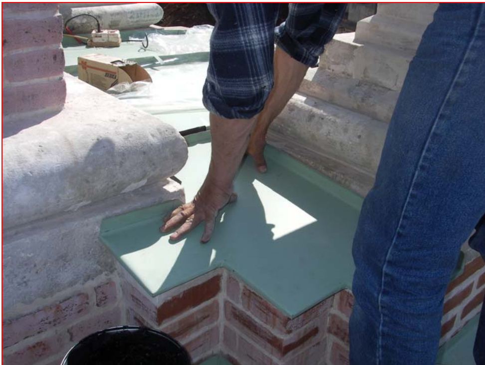
Bild 15 : Verklebte Abdeckung
