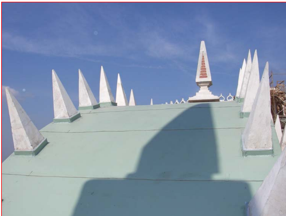
Bild 19 : Verklebte Bogenabdeckung
