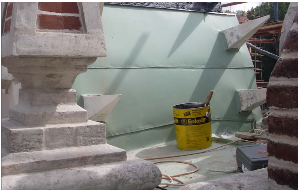
Bild 10 : Arbeiten mit ENKOLIT
