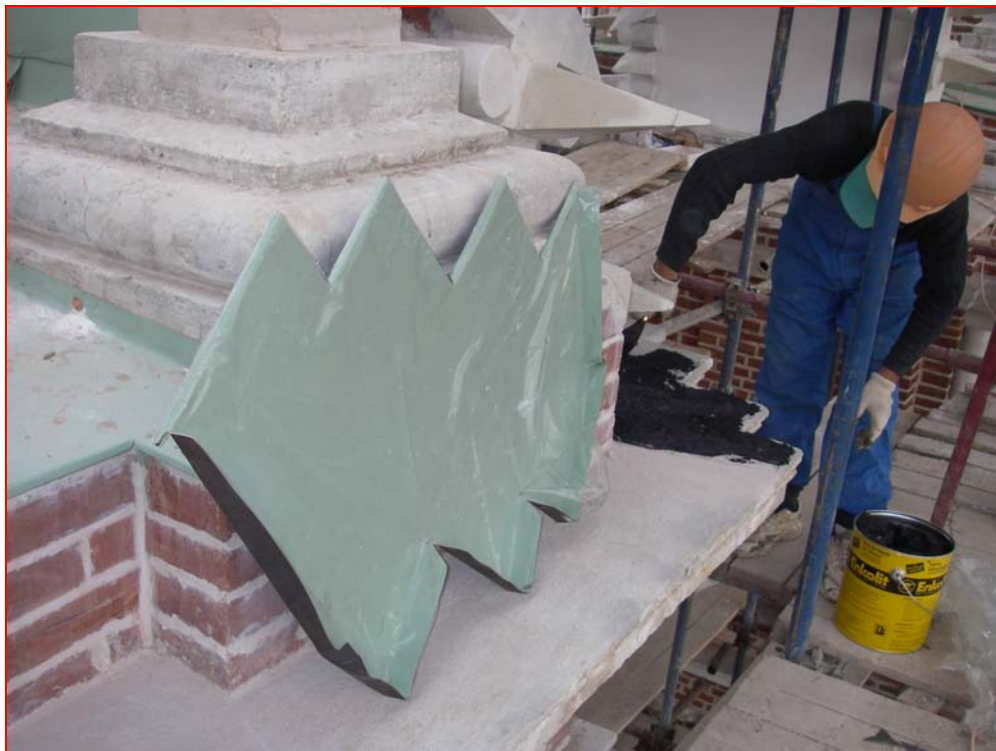
Bild 12 : Arbeiten mit ENKOLIT
