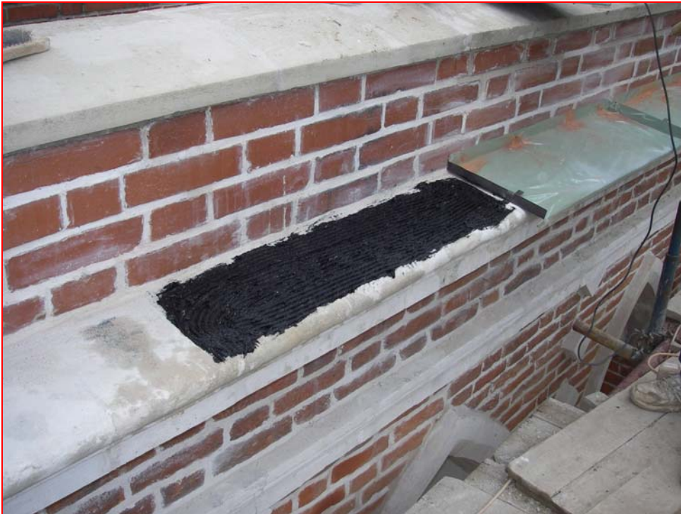
Bild 14 : Arbeiten mit ENKOLIT
