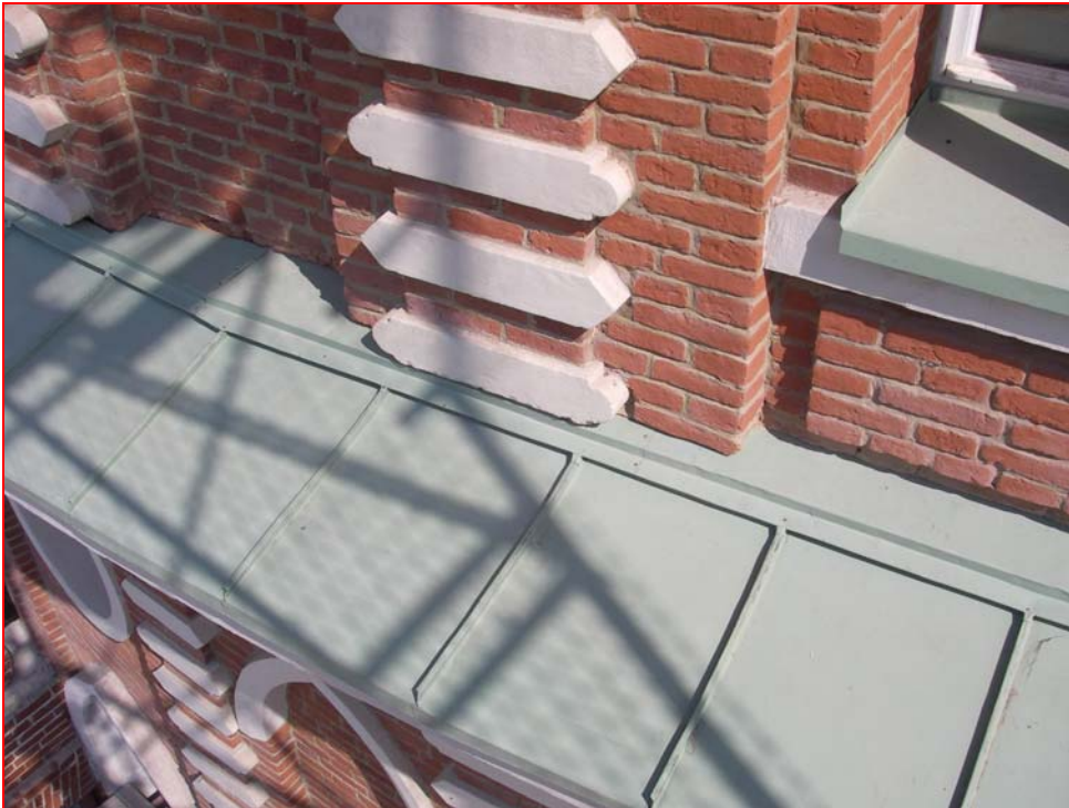
Bild 20 : Verklebte Gesims- und Fensterbankabdeckung
