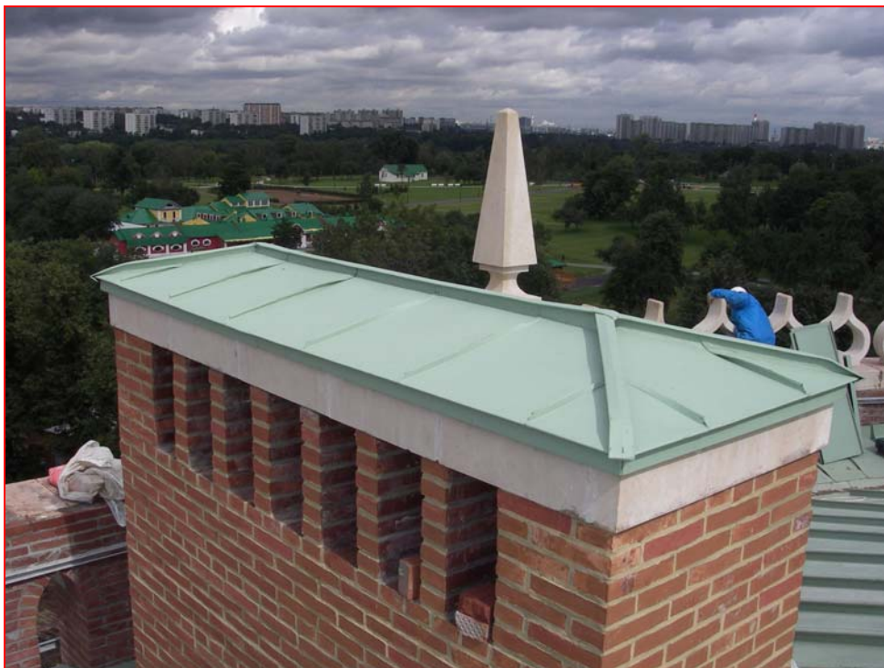
Bild 17 : Verklebte Kaminabdeckung
