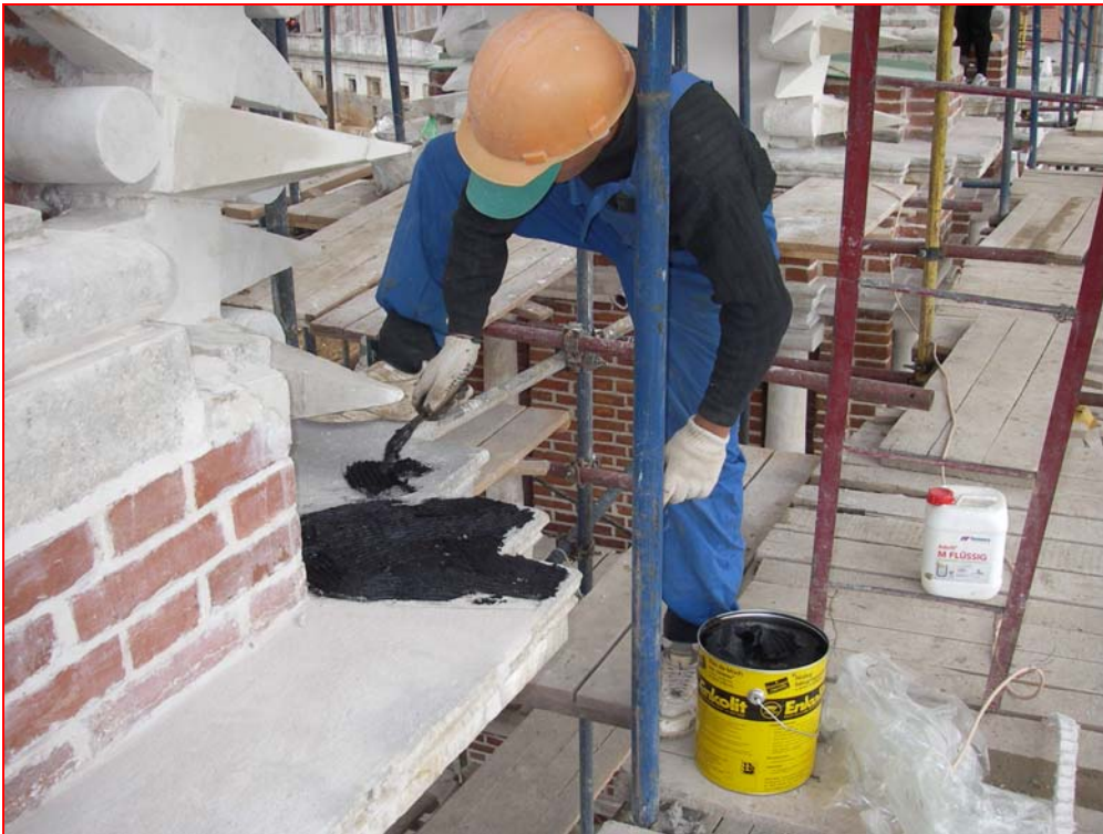
Bild 11 : Arbeiten mit ENKOLIT
