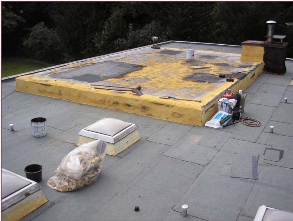
Hohllagen abstoßen, auffüllen und mit einer SK-Bahn schützen
