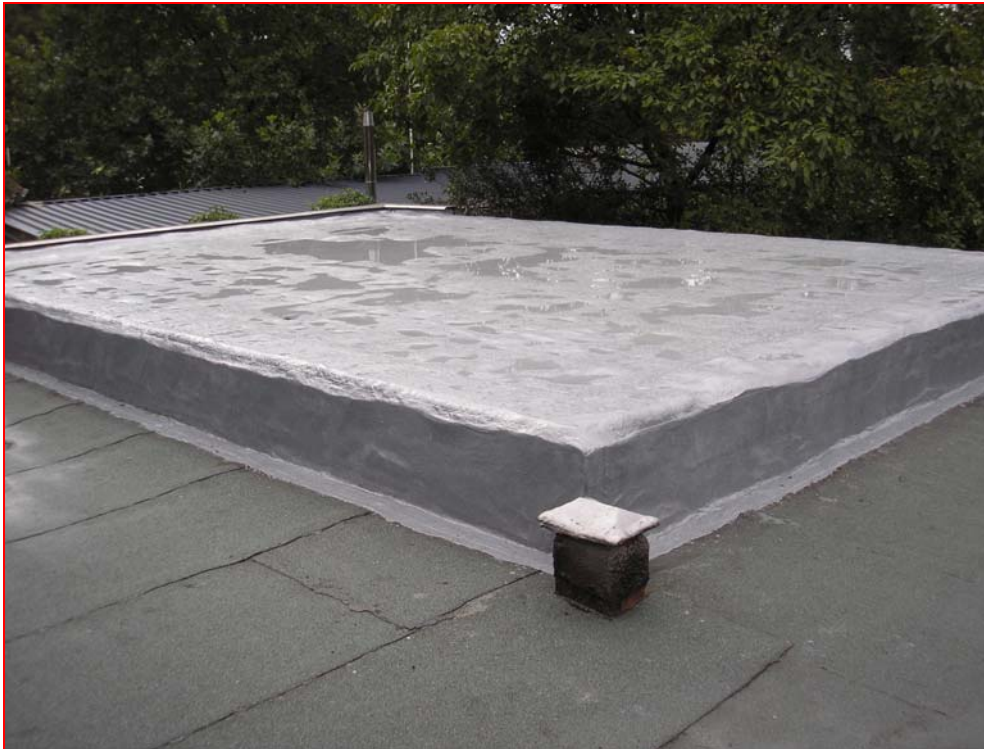
Fläche und Anschlüsse abdichten
