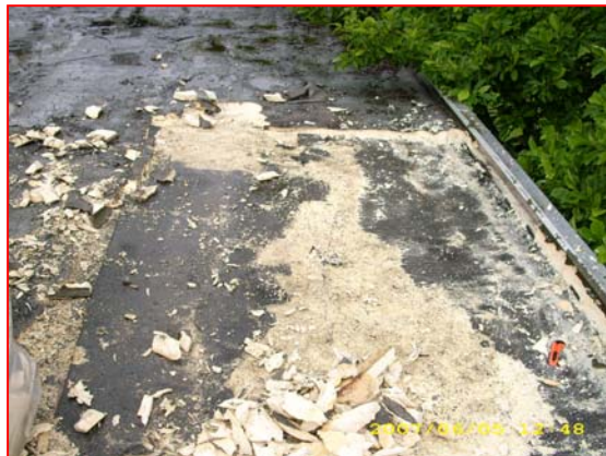
Abriss des alten PUR – Schaums
