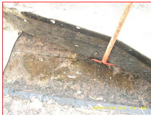
Abriss der alten Abdichtung
