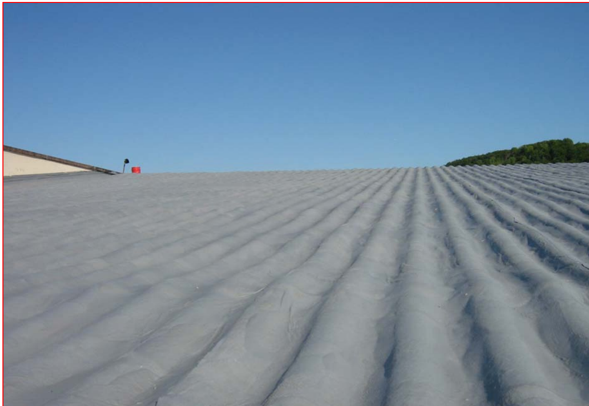
mit Enkryl / Polyflexvlies komplett abgedichtete, wetterfeste und diffusionsoffene Dachfläche
