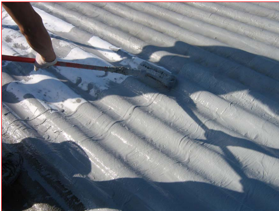
Verarbeitung von Enkryl mit der Lammfellrolle
