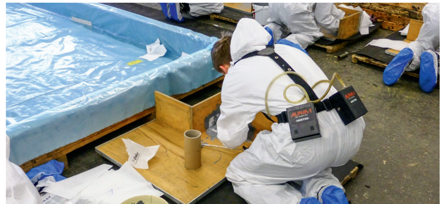
Der Testaufbau: Unter Anleitung einer Lehrkraft führen 16 Dachdecker Azubis Probearbeiten an Modellstücken durch. Raummaße: 18 m x 10,8 m x 3,3 m. Innentemperatur: 19,2 °C bei sonnigen Außenbedingungen.
